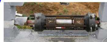
Horizontální táhla v čelní stěně
